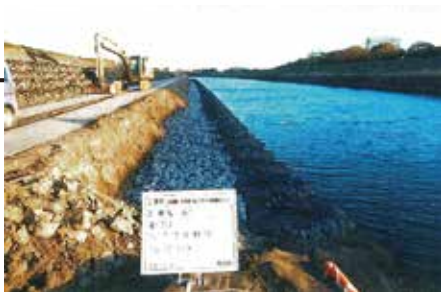
① 中川(河川改修)
